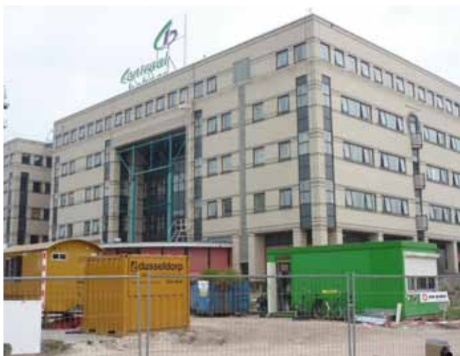
Brakel Atmos verving de 37 glazen daken van het hoofdkantoor van CBM Achmea.
